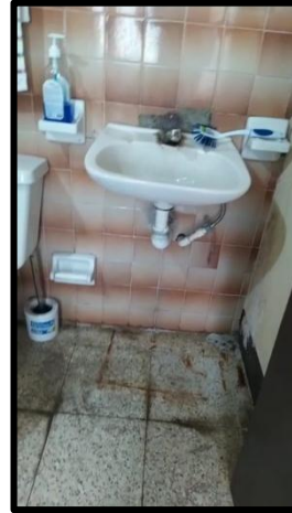
Selección del espacio para instalación de filtro
