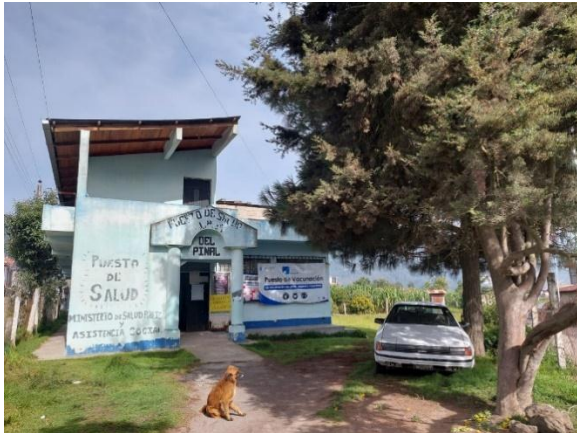
Área Verde y parqueo del puesto de salud
