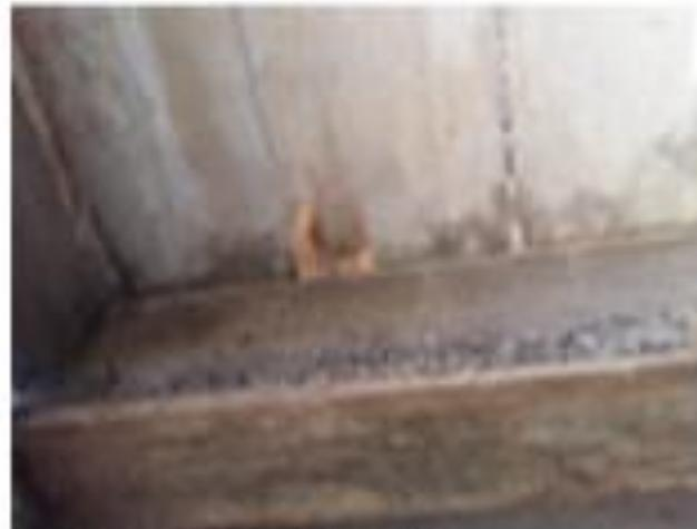
Fundición incorrecta de solera
