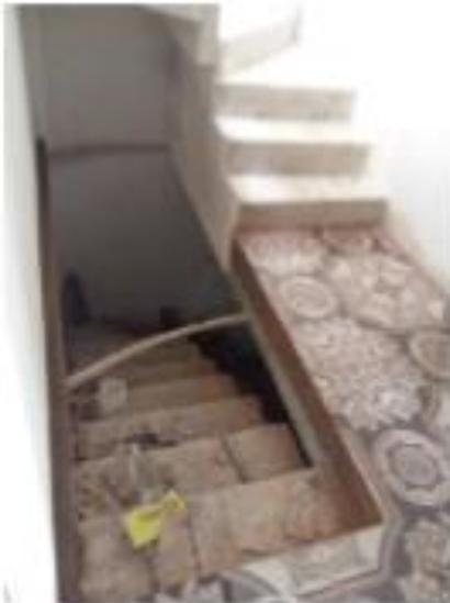
Vista del módulo de gradas (se observa el relleno de 15 cms de contrapiso)
