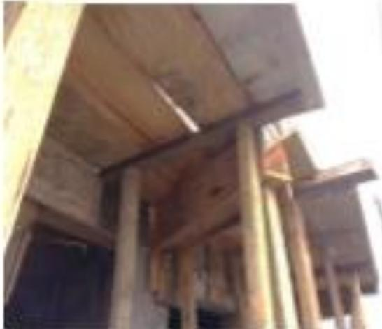
Baja calidad de madera de encofrado
