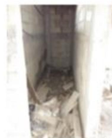
Dentro de la obra se observa en el suelo, clavos y restos de madera con clavos; esto podría causar accidentes.
