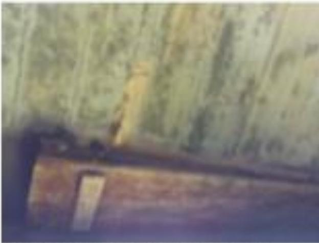
Madera de encofrado adherida a losa
