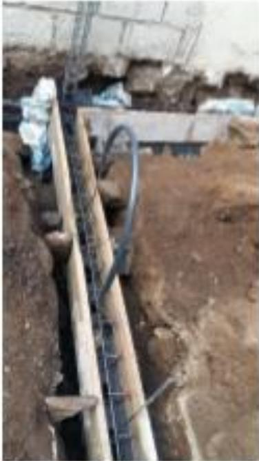
*Encofrado y armado de solera hidrófuga*
