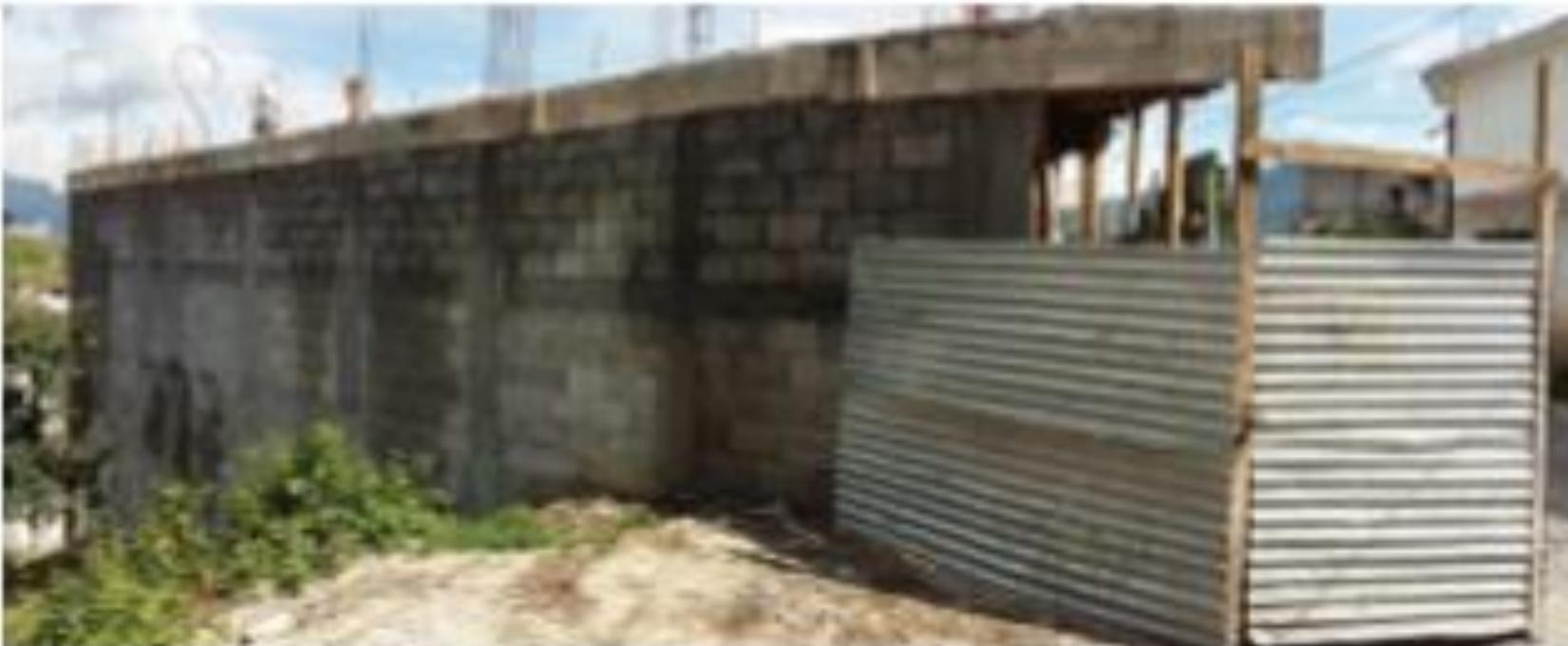
Vista norte, muros humedecidos por inundación de losa
