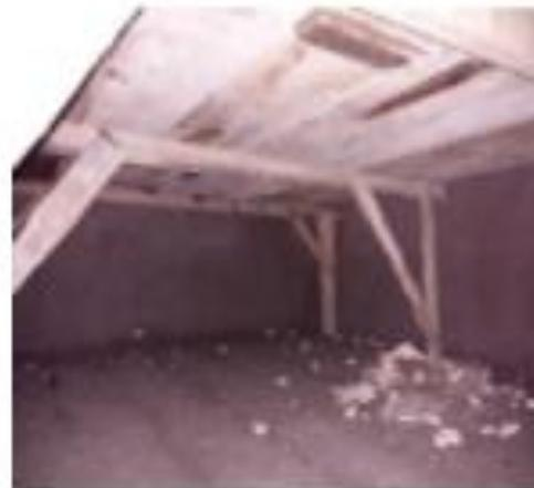
Entramado colocado en una de las habitaciones, utilizado como andamio para aplicar repello en el techo
