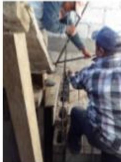
Personal colocando armadura de gradas
