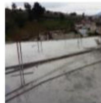
Varillas de acero sobre losa inundada
