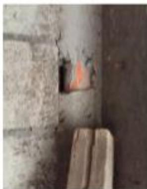
En muros se observa que el espacio de las bajadas de agua e instalaciones hidráulicas se fundieron mal
