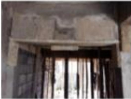
Incorrecta ejecución de dintel (defectuado)
