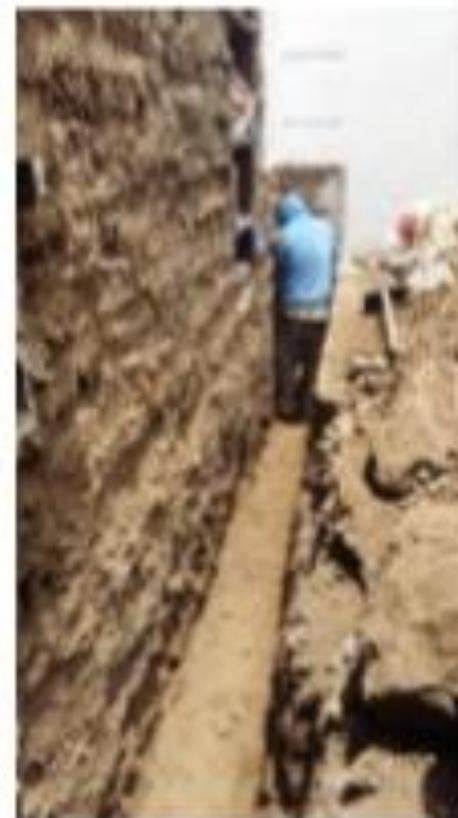
Maestro de obra verificando profundidad de zanja
