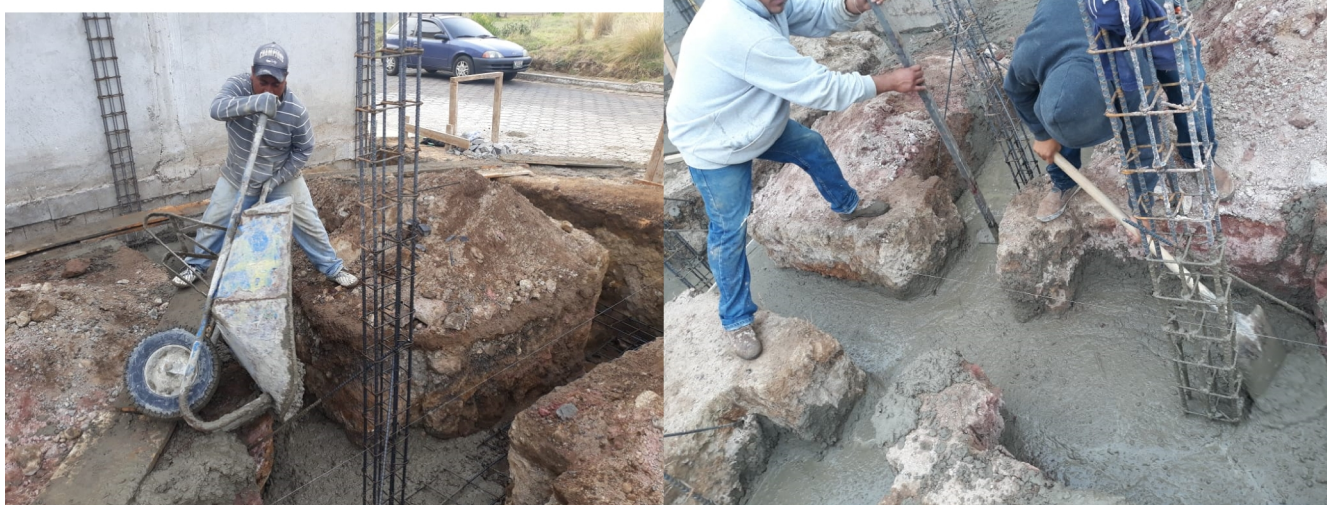
Fundición de zapatas y cimiento corrido.
