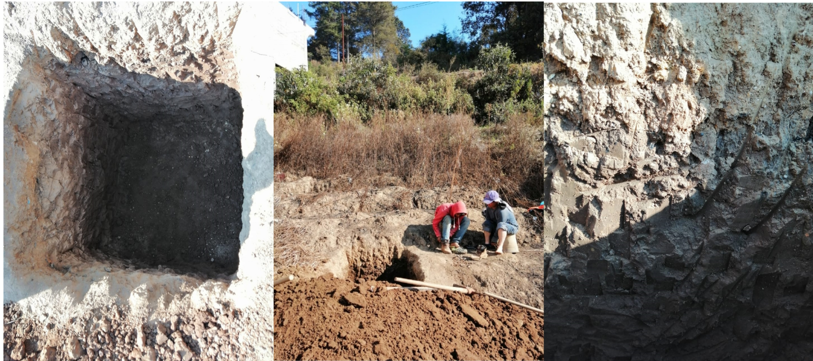
Trazo, excavación de pozos para zapatas
