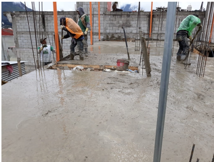
Fundición de losa y solera entrepiso.
