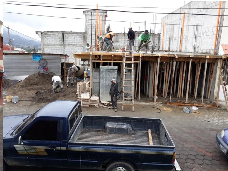
Fundición de losa y solera entrepiso.
