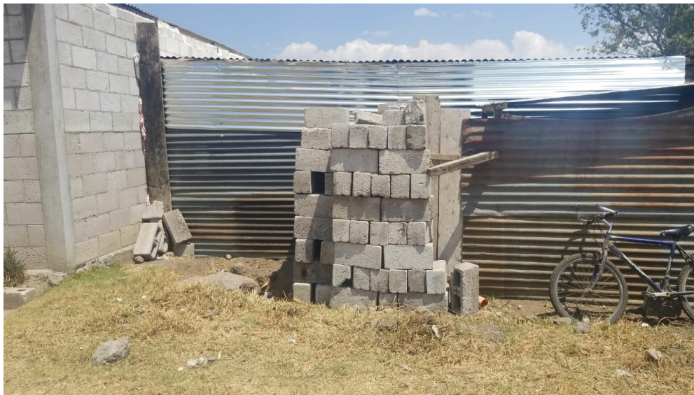
Construcción de infraestructura provisional Bodega para el almacenamiento de material del proyecto.
