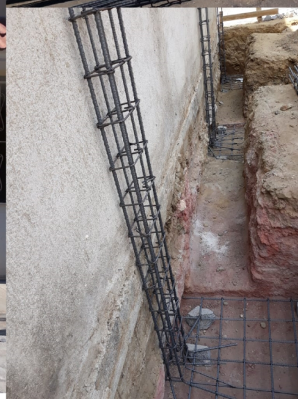
Elaboración, colocación, centrado de armado de cimiento corrido y zapatas.
