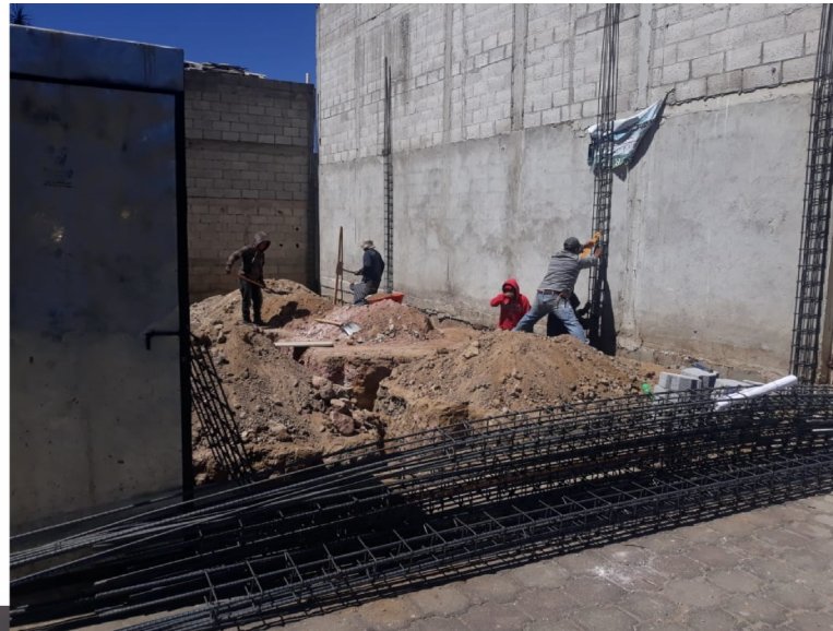
Elaboración, colocación, centrado de armado de cimiento corrido y zapatas.
