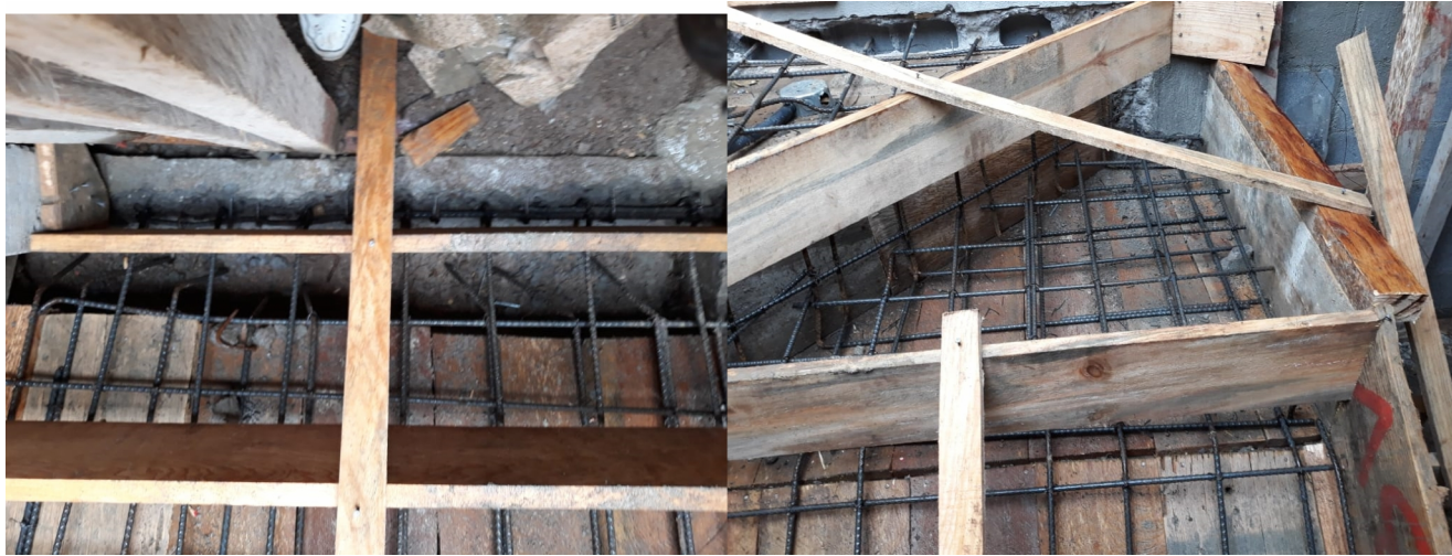
Armado y encofrado de gradas.
